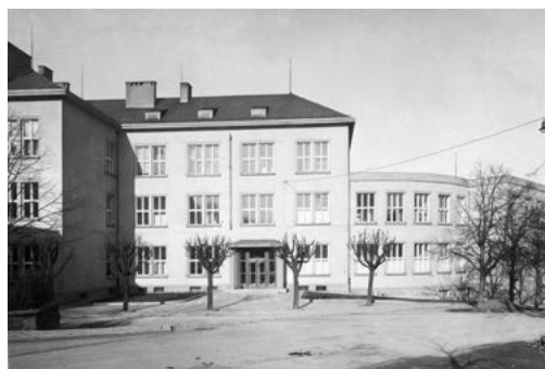
← Moravskoostravská spošitelna, Moravská Ostrava, nám. Dr. E. Beneše 6, 1927–1930
