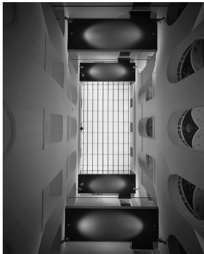
I. Koleček, V. Rudiš, Z. Vydrová, rekonstrukce Uměleckoprůmyslového muzea v Brně, 1998–2001
